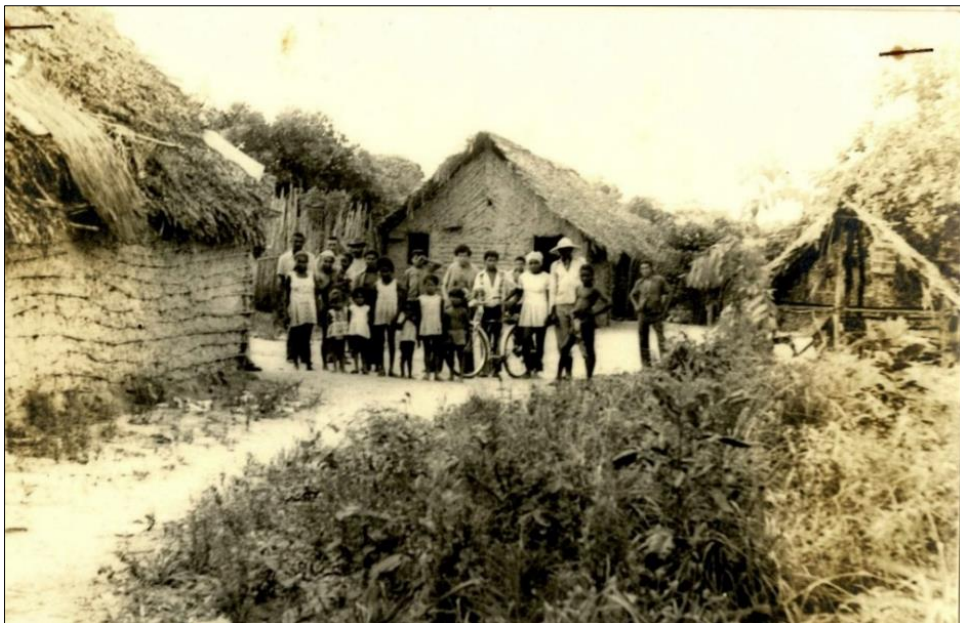
Figura 5 – Moradores de Aldeia e Seus Casebres Destruídos Pelo Incêndio
